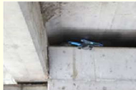
橋梁下の画像計測例
