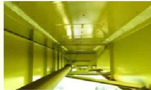
桁内の撮影例
